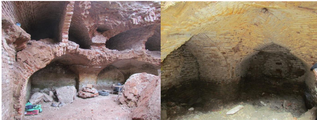
Рис 6. Конструкция перекрытия западного караван-сарая.
