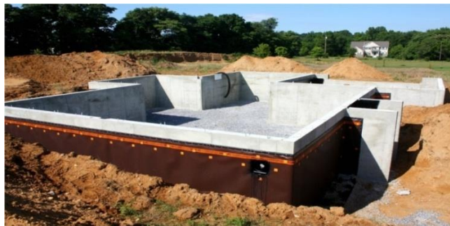
6-расм. Биноларнинг нам ўтказмаслик хусусиятига эга бўлган ва пойдевор конструкциясига қўшимча иссиқлик изоляцияси билан жихозланган курсиси.
