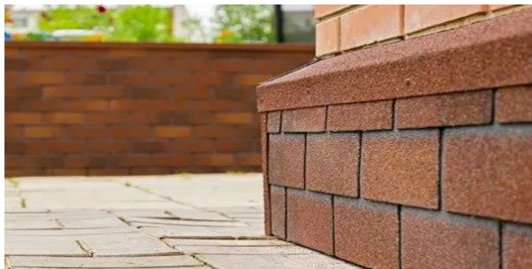
8-расм. Бино курсиси девор қалинлигидан бўртиб чиққан, пойдевор конструкциясиларига мос бўлган замонавий қурилиш материалларидан фойдаланилган плиткалар билан безатилган курсиси.
