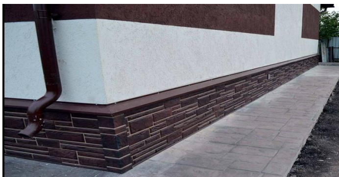
12-расм. Биоларнинг пойдевор конструкциялари тош плиталаридан терилган курси.
