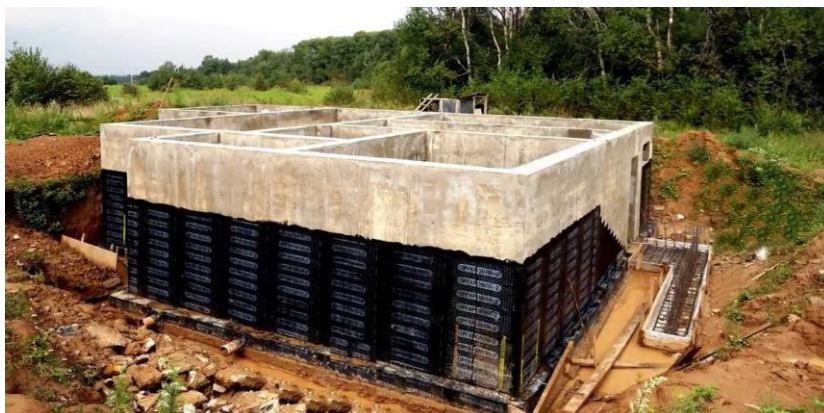
4-расм. Замонавий биоларнинг пойдевор қисмида нам ўтказмаслик хусусиятига эга бўлган қўшимча изоляцион конструкцияли курси.
